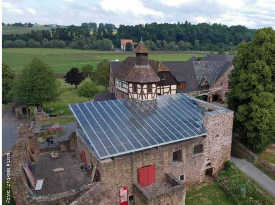
Die Herrenhausruine des denkmalgeschützten Wasserschlosses Wülmersen präsentiert sich jetzt mit einer vollständigen Überdachung. Der Clou: die Verbindung mit einer lichtdurchlässigen Photovoltaikanlage.
