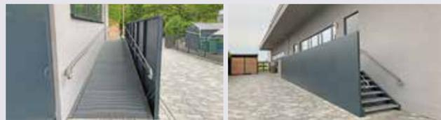
Die prägnante Anlieferungsrampe mit Treppe und Geländer aus beschichtetem Stahlblech, die Innengeländer, die Handläufe, das Innenrolltor, das Küche und Speisesaal trennt, sowie verschiedene Schutzvorrichtungen für den Dachausstieg und den Notausstiegschacht: Auf Schritt und Tritt begegnen den Nutzern des neuen Grundschulbaus Sonderanfertigungen der Firma Brede Metallbau aus Zierenberg.
