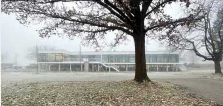
Servicegebäude für den Kasseler Campingplatz
