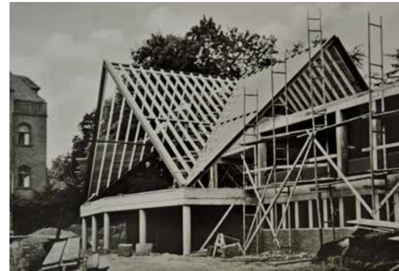
Standort: Goethestraße 85, 34119 Kassel Baujahr: 1962 (Kirche), 1983 (Glockenturm) Bauherr: Kurhessisches Diakonissenhaus Kassel Architekt: Dipl.-Ing. Wolfgang Haeseler, BDA Fotos: Kurhessisches Diakonissenhaus
