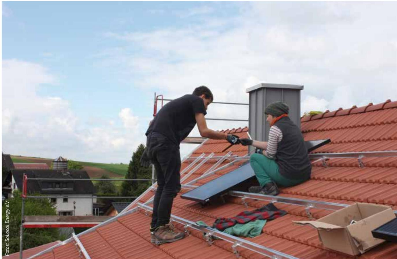
Solarselbstbau: Die ersten Module werden verlegt.
