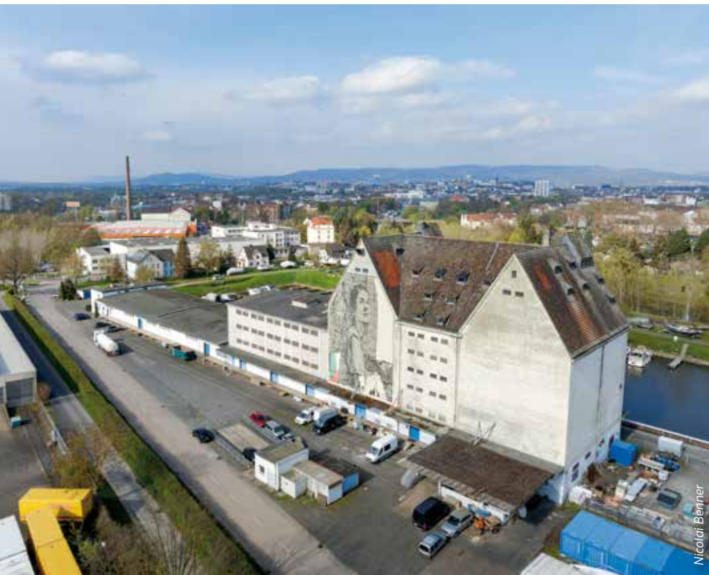
Blick auf das denkmalgeschützte Silobauwerke.
