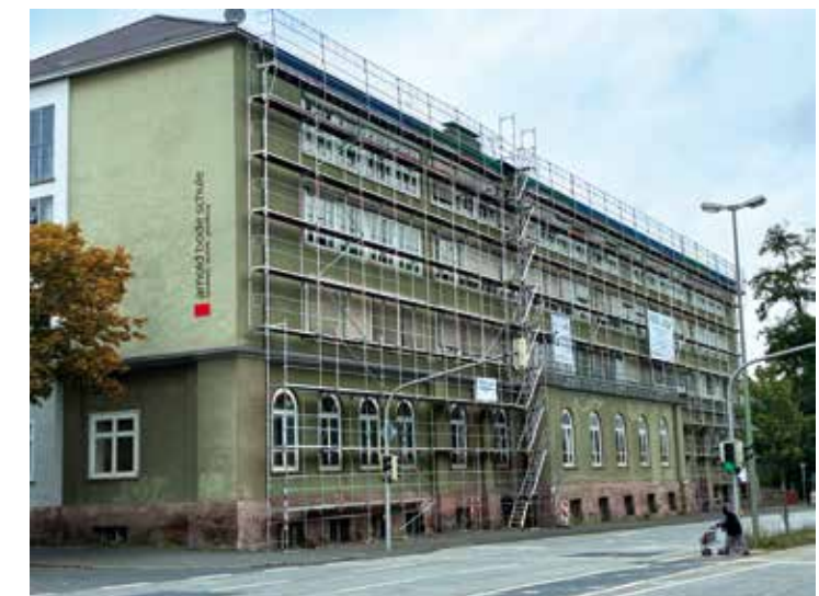
Auf dem Dach der Arnold-Bode-Schule im Schillerviertel entsteht eine Photovoltaikanlage.
