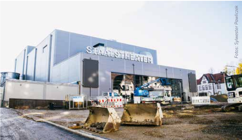
Die neue Spielstätte INTERIM kurz vor der Eröffnung am 31.10.2025 mit letzten Arbeiten am Vorplatz.
