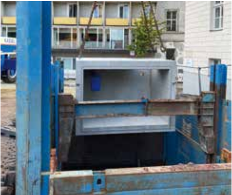
Einbau der ersten Zisterne.
