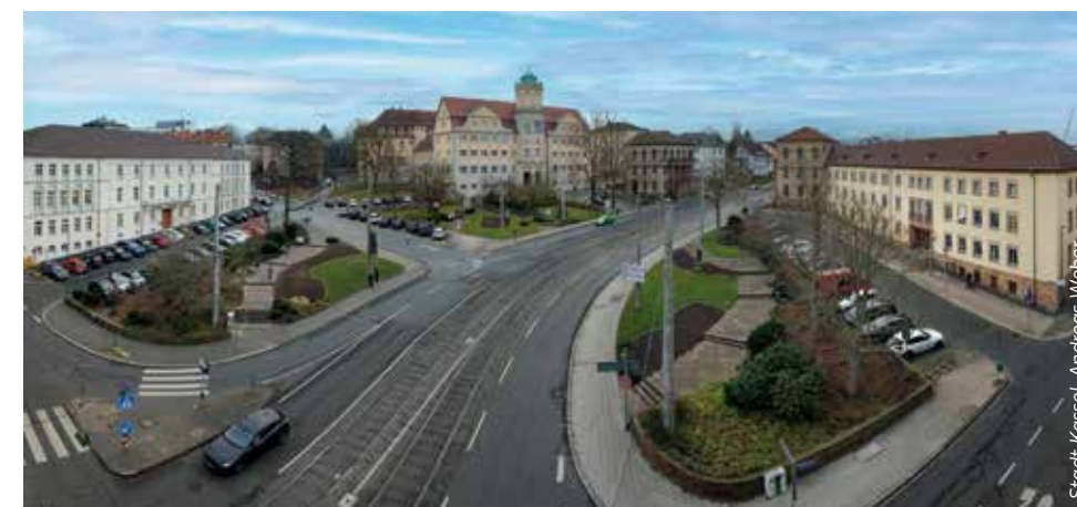
Zustand vor dem Umbau, Januar 2020.
