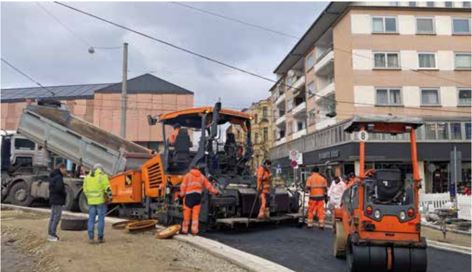
Kurz vor der Fertigstellung: Asphaltarbeiten in der Friedrichsstraße.
