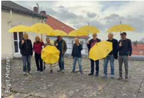
Da helfen selbst Regenschirme nicht mehr, das Dach dicht zu bekommen.
