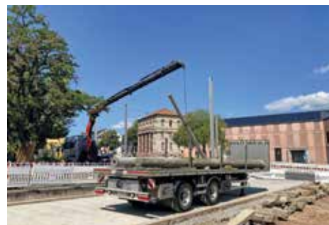
Mastaustausch: Abbau und Abtransport der alten Masten
